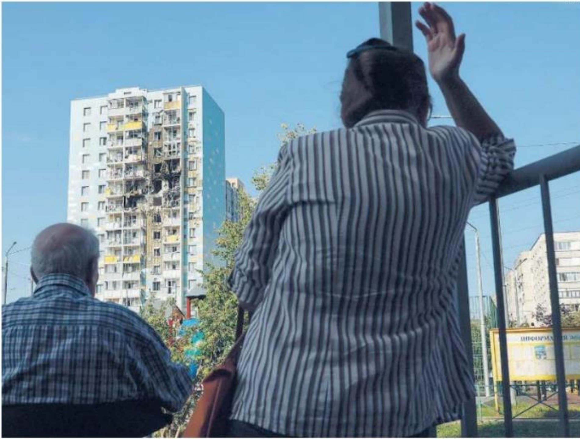
Vecinos miran impactados los daños de un edificio de viviendas a las afueras de la capital rusa, ayer
